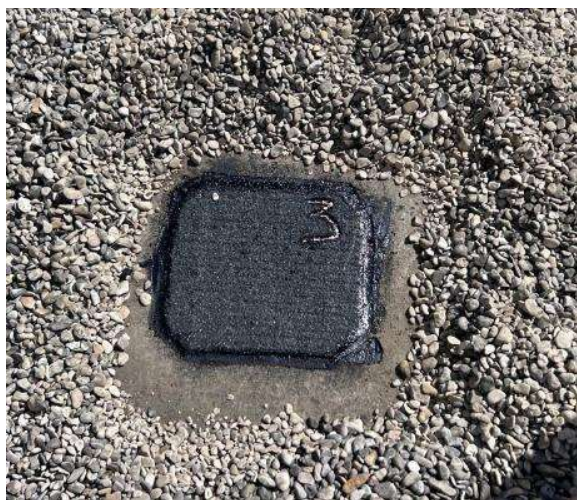
Fermeture du sondage
